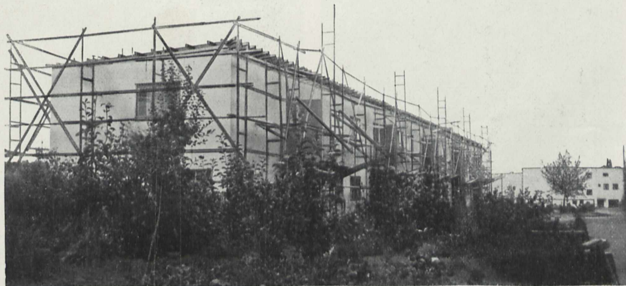
Fig. 7. Das zunächst gesimslose Flachdach, welches im ersten Jahre zahllose Reparaturen erforderte und umfangreiche Zerstörungen des Mauerwerks veranlaßte, wurde zur endgültigen Behebung der Schäden durch ein zweites, im Gefäll verlegtes Sparrendach überdeckt. Die weit vorspringenden Sparrenköpfe werden zum „verpönten“ Hauptgesims.
