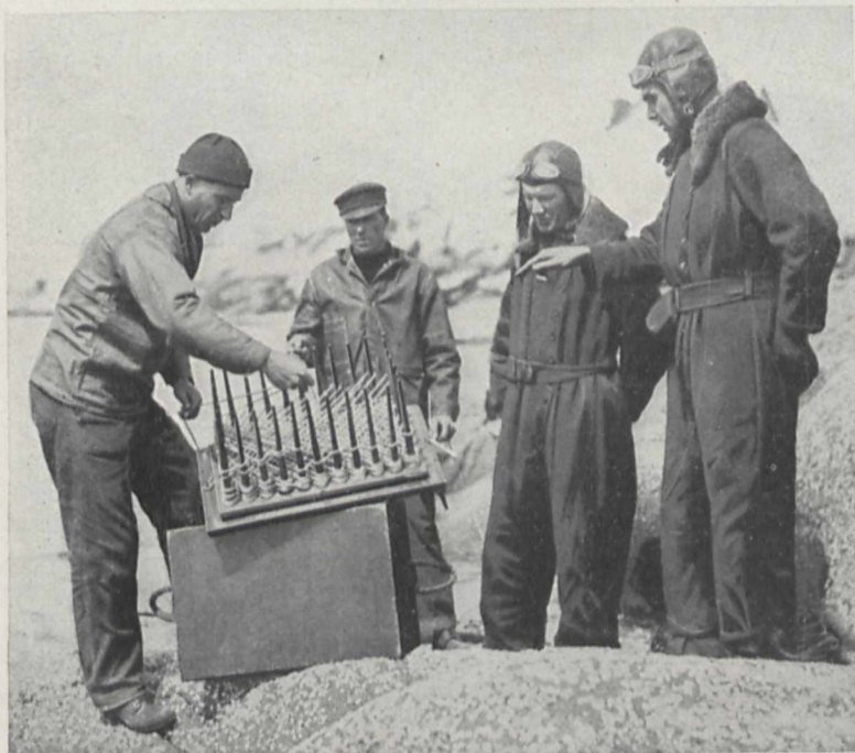
Fig. 2. Wie die Rettungsleine aufgewickelt ist, damit sie sich bei dem raschen Abziehen durch das Flugzeug nicht verwirrt. phot. U. S. Coast Guard
