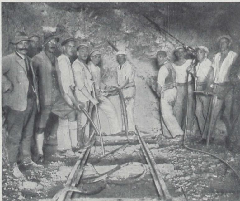
Fig. 7. Bohrstelle im Tunnel. Phot. Weiss
