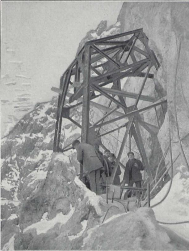
Fig. 5. Aufstellen einer Hilfs-Seilbahnstütze bei Fenster 3 im festen Fels. Phot. v. Römer
