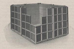
60×60 cm Flächenmaß und in der Regel 7 mm Dicke zur Verwendung kommen. Entsprechend dieser geringen, statisch aber wegen Wegfalls der Zugspannungen noch immer weitaus überdimensionierten Wandstärken ist bei großen Tankabmessungen der neue gußeiserne Plattentank nur um wenig schwerer als genietete oder geschweißte, rechteckige Blechbehälter gleichen Fassungsraumes.
