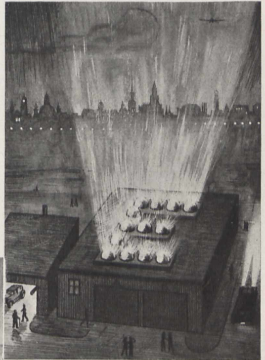
Fig. 3. Das Kennzeichen (E) des Flughafens ist aus Glashalbschalen mit Innenreflektoren gebildet
