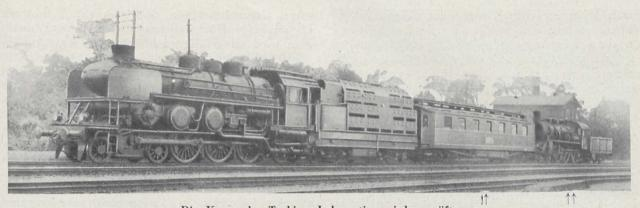
Die Kruppsche Turbinen-Lokomotive wird geprüft Hinter der Lokomotive mit Tender befindet sich der Meßwagen (↑), am Schluß des Zuges eine Lokomotive mit Gegendruckbremse (↑↑) als Ersatz für eine längere Wagenreihe und Steigungen
