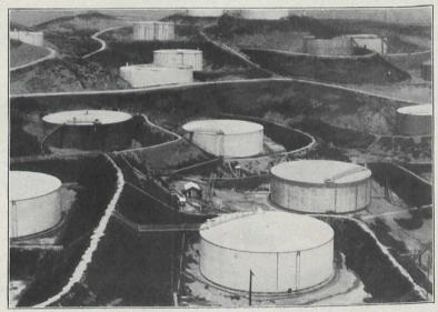
Fig. 5. Modernste Erdöltanks in Californien sind mit hohen Erdwällen umgeben, die das Petroleum bei einem evtl. "Ausbruch" am Abfließen verhindern und dadurch die Ausbreitung eines Petroleumbrandes verhüten Phot. International Press Bureau
