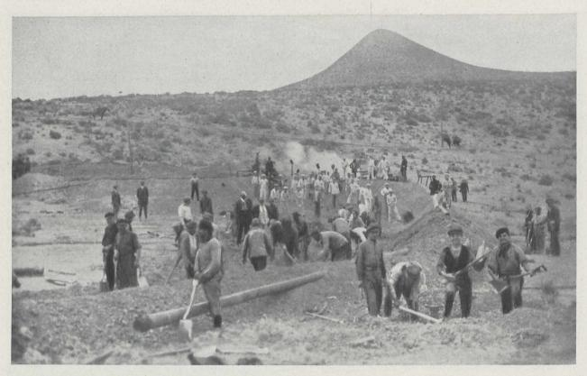
Fig. 4. Marinesoldaten, die zur Verstärkung der Arbeiterschaft herbeigerufen wurden, werfen Dämme auf, um das "ausgebrochene" Petroleum aufzustauen (auf den Staatl. Argentinischen Oelfeldern)
