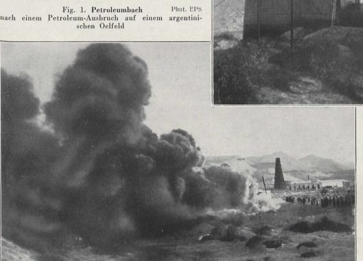
Fig. 3. Petroleum-Ausbruch aus Turm 128 der staatlichen argentinischen Oelfelder Das Erdöl sprengte die Sicherheitseinrichtungen und ergoß sich über das Gelände, wo man ihm Bachbetten grub, um es wieder zu sammeln Phot. EPS
