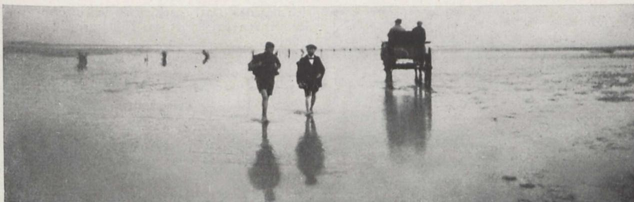
Fig. 1. Der Wattenweg zwischen Dühnen und der Insel Neuwerk ist, unter Umgehung weicher Stellen und großer Muschelbänke, durch harten Sand geführt und durch eine Buschreihe bezeichnet. Diese muß jedes Jahr erneuert und sehr oft um weite Strecken seitwärts verlegt werden. Die Furt ist, wie die Kleidung der Fußgänger zeigt, bei günstigem Niedrigwasser nur knietief.
