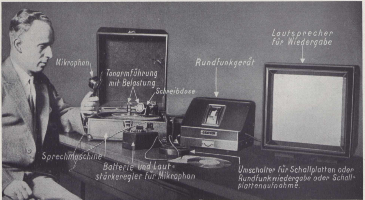
Fig. 4. So arbeitet man mit dem Schallplatten-Selbstaufnehmer für Aluminium
