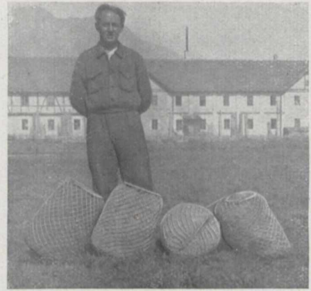
Fig. 4. Kohlen- und Zementsäcke in Drahtnetzen für den freien Abwurf.
