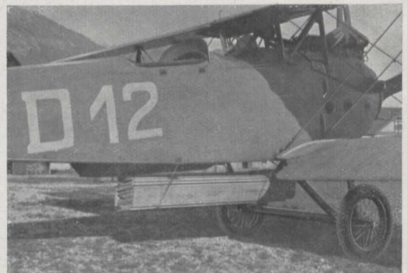
Fig. 6. L.V.G. C 6-Doppeldecker für Höhenfracht. Sperrige Güter werden unter dem Rumpf aufgehängt.
