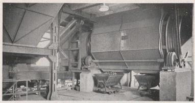
Fig. 3. Beim Aufbereitungsprozeß in neuzeitlicher Müllverwertung werden sperrige Metallteile durch Elektromagneten entfernt und der "Feinmüll" (Asche) gesondert aus der Trommel abgesiebt
