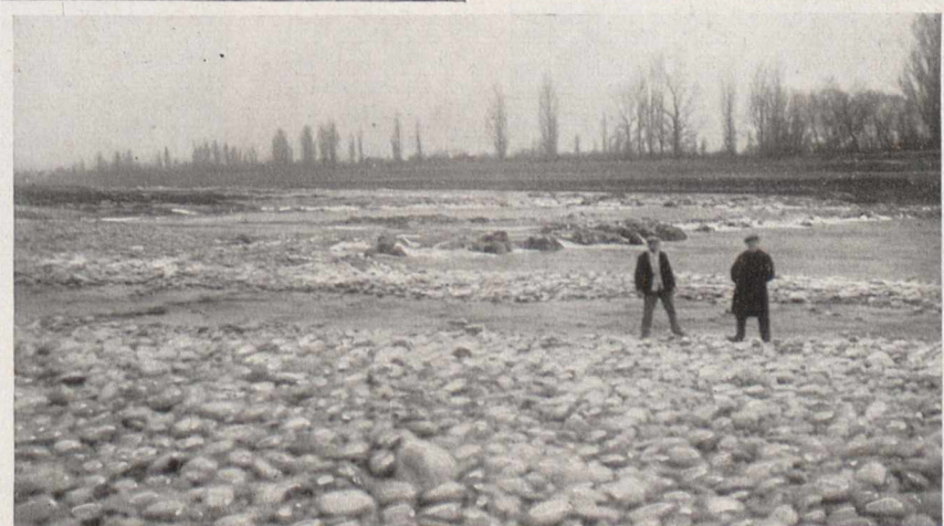
Fig. 6. Das Rheinbett bei Istein ist durch die Ableitung des Wassers in den Rheinseitenkanal bei ca. 25 cbm/Sek. Wasserführung bloßgelegt. Blick vom badischen Ufer über die Kiesbänke und die aus dem Wasser anstehenden Felsen der Barre nach dem elsässischen Ufer hinüber.
