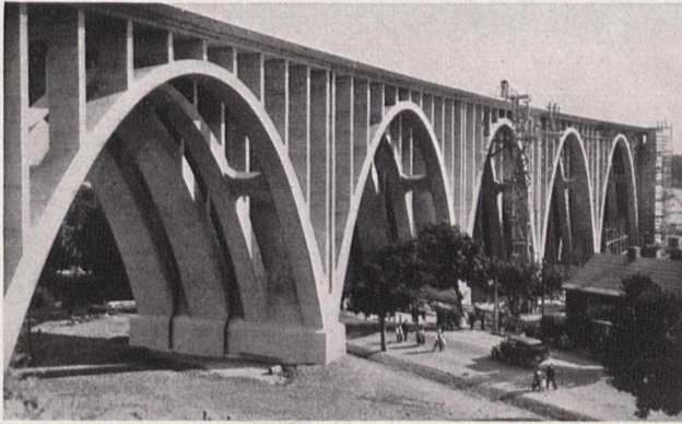
Fig. 3. Die fertiggestellten 5 Eisenbetonbogen auf der jütländischen Küstenseite. Fig. 4 rechts. Zwei Strompfeiler. Der vordere bereits versenkt und vergossen, der hintere gekippt und zum Versenken bereit.
