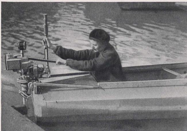
Fig. 1. Das Anwerfen des Motors am Motorfaltboot mit Spiegelheck
