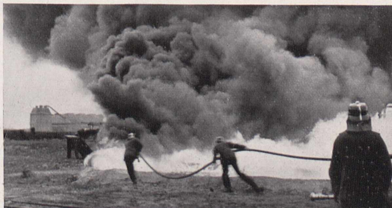
Fig. 3. . . wurden mit Wasser aus der Steinschen Universaldüse in wenigen Sekunden gelöscht. — Die feinen Wassernebel verwandeln sich durch die Brandhitze in weiße Dampfwolken.
