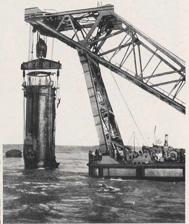
Fig. 2. Versenken einer der Eisenbeton-Hohlsäulen, auf denen die Mole ruht
