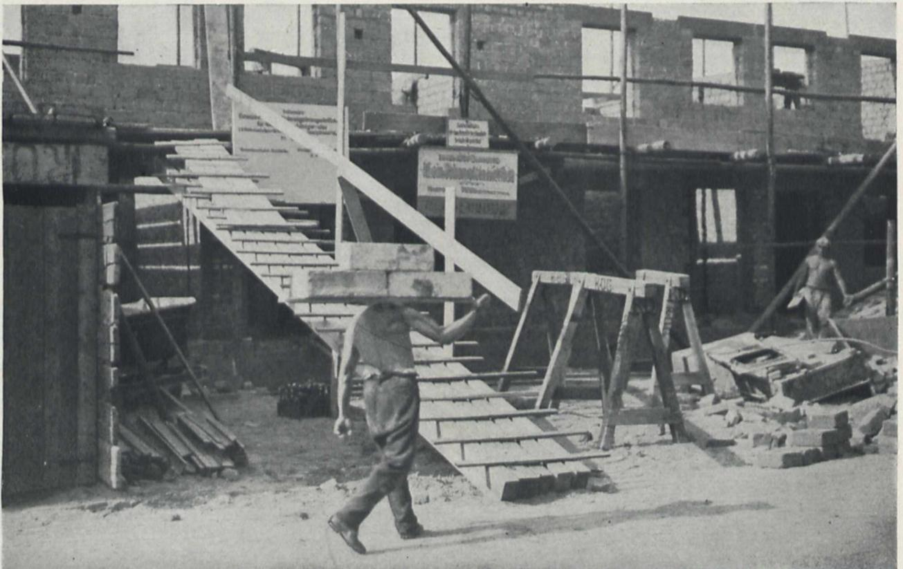
Fig. 2. Bausteine aus Iporit-Leichtbeton haben ein so geringes Gewicht, daß eine Person drei mächtige Klötze tragen kann.
