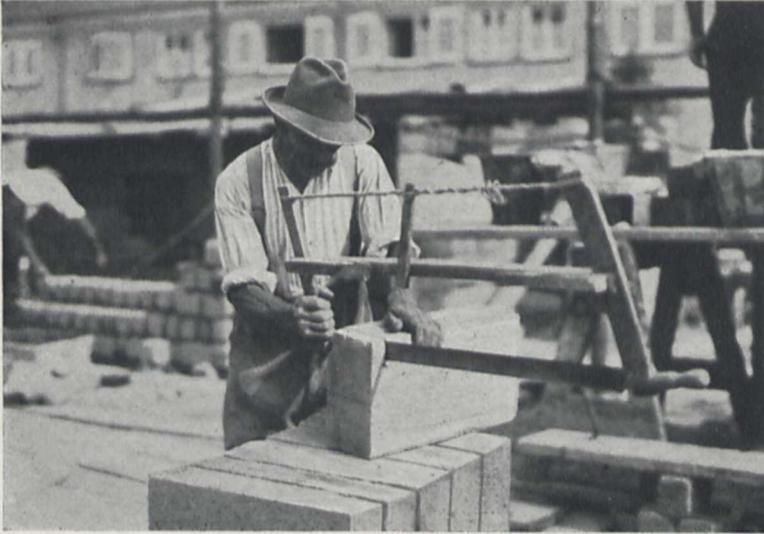
Fig. 1. Leichtbeton läßt sich sägen.
