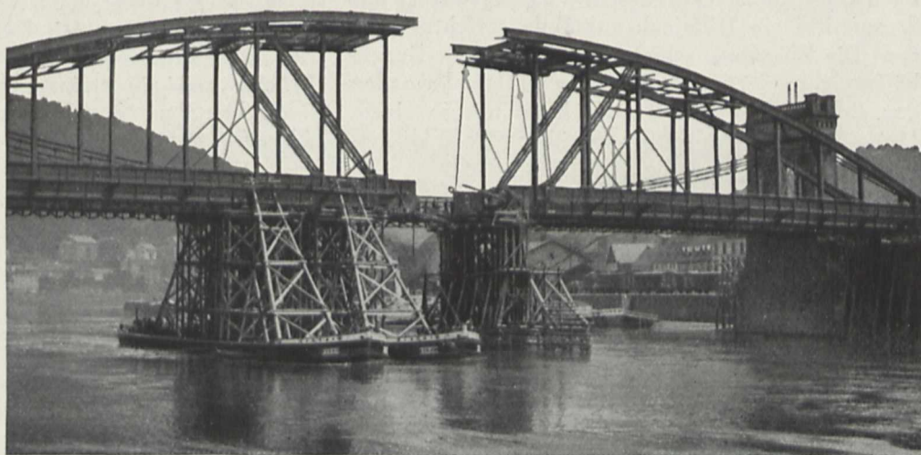
Fig. 2. Die Brückenhälften sind schon nahe aneinandergeschoben Phot. A. Kraus
