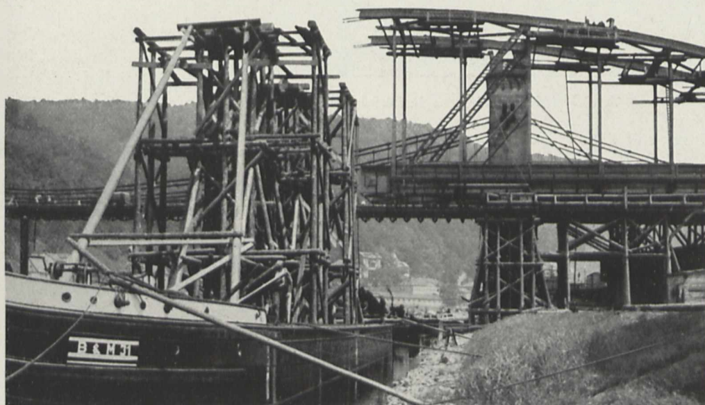
Fig. 1. Beim Neubau der Elbbrücke zwischen Tetschen und Bodenbach werden die Brückenhälften mit Gerüstkähnen (im Vordergrund des Bildes) zusammengeschoben
