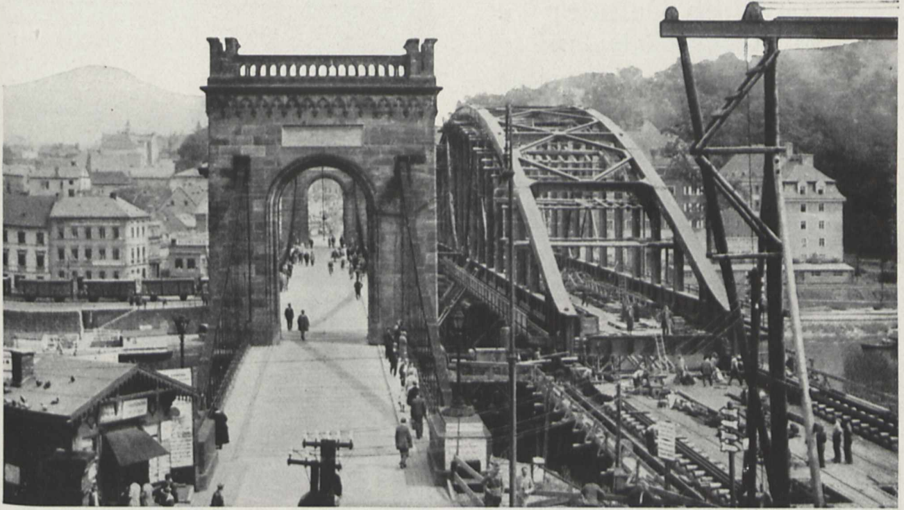
Fig. 5. Neben der alten Kettenbrücke (links) ist der Neubau (rechts) fertiggestellt; dann wurde die alte Brücke abgebrochen (vgl. Fig. 4) und die neue an ihre Stelle geschoben
