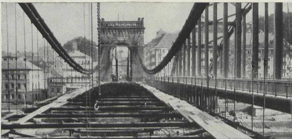
Fig. 4. Abbruch der alten Kettenbrücke
