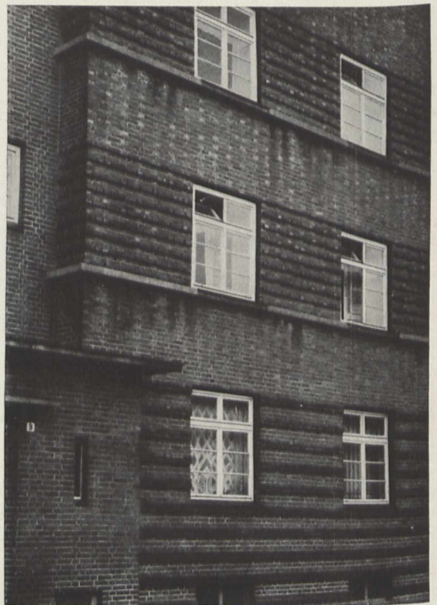
Fig. 6. Falsches Gesimsprofil, das ein Abtropfen des Regens durch Wassernase nicht ermöglicht, führt zur Durchnässung und Verschandelung der Frontwände
