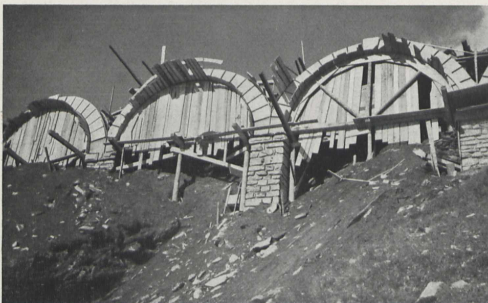
Fig. 5. Das Tonnengewölbe für den Parkplatz Franz-Josefs-Höhe im Bau
