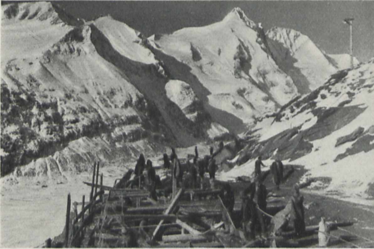
Fig. 1. Der Parkplatz Franz-Josefs-Höhe im Bau
