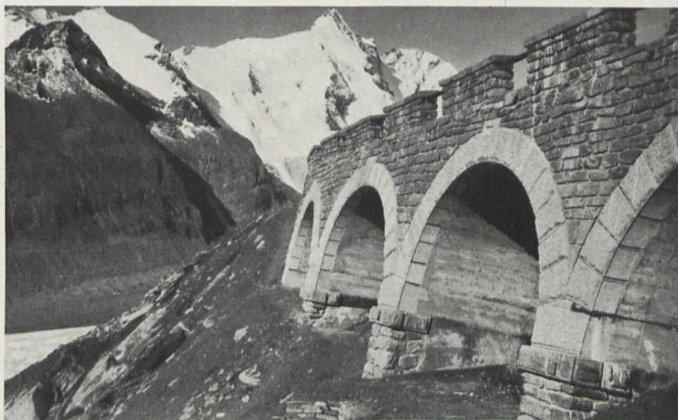
Fig. 4. Das Tonnengewölbe, auf dem der Parkplatz Franz-Josefs-Höhe ruht Links unten, 200 m tiefer, der Pasterzengletscher
