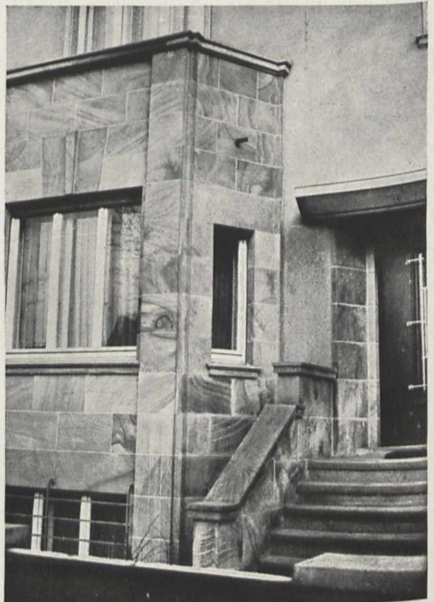
Bild 3. Die Spritzer von der Treppe bedingen häßlichen Schmutz und Algenansatz am unteren Teil des Erkervorbau und am Vorbau über dem Hauseingang
