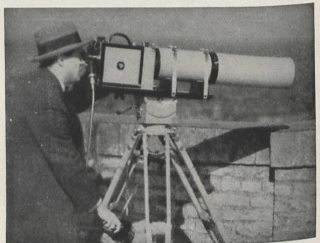
Bild 6. Kamera mit Spiegellinsenobjektiv zur Aufnahme entfernter Objekte. — Trotz seiner Leistungen ist die Länge des Objektivs nur 46 cm.
