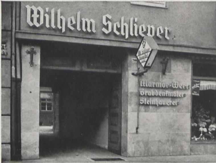
Bild 7. Die Buchstaben stehen von der Wand ab. — Dadurch werden die häßlichen Triefspuren durch Regen vermieden (vgl. Bild 6).
