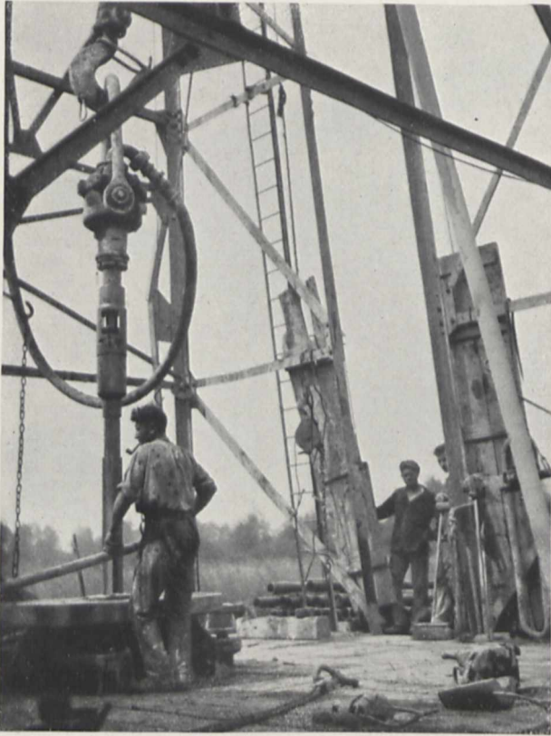
Bild 5. Am Flaschenzug im Bohrturm hängen Mitnehmerstange, Gestänge und Bohrer
