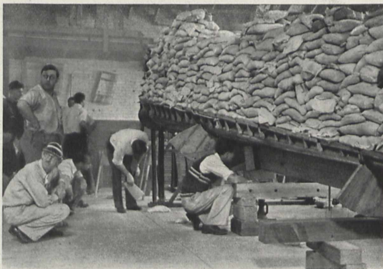
Bild 5. Belastungsproben zur Ermittlung von Ermüdungserscheinungen
