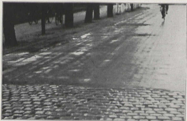
Bild 5. Abdeckung alten Pflasters mit Teer oder Kaltasphalt
