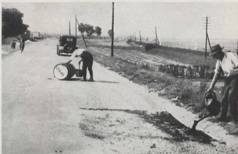
Bild 2. Straßenverbreiterung im Tränkverfahren
