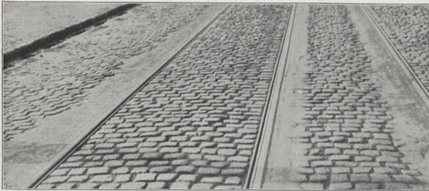
Bild 4. Fugendichtung an den Straßenbahnschienen mit Teersplitt oder Kaltasphalt
