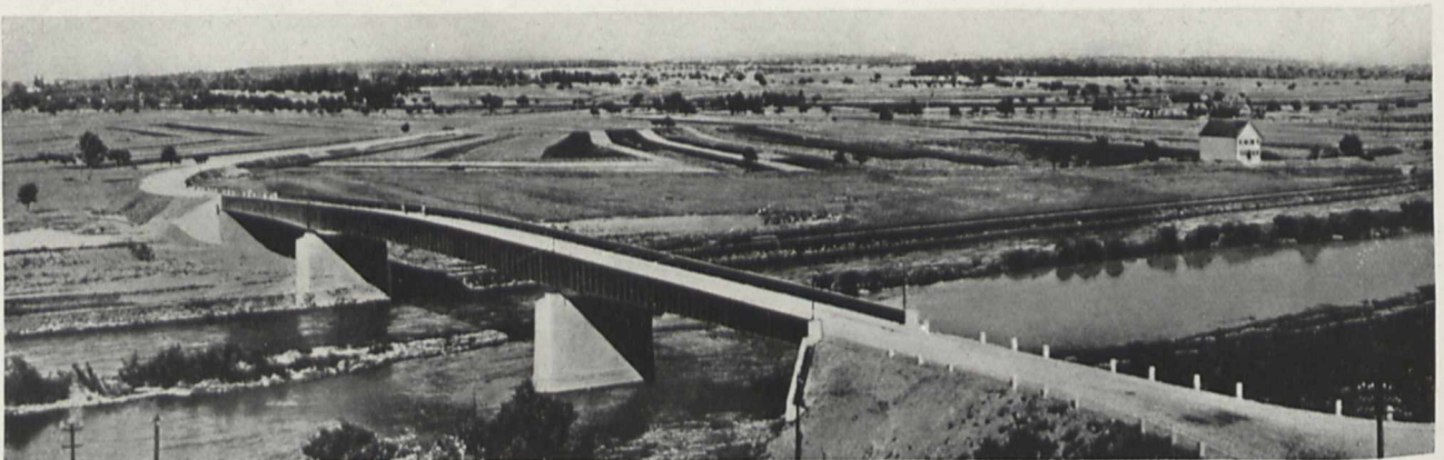
Bild 1. Hindenburgbrücke bei Wimpfen Einfach im einfachen Landschaftsbild führt die Brücke aus Stahl über den Neckar
