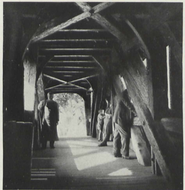
Bild 4. Die feste Holzkonstruktion hält Wind und Wetter ab. Brücke in Schwäbisch-Hall
