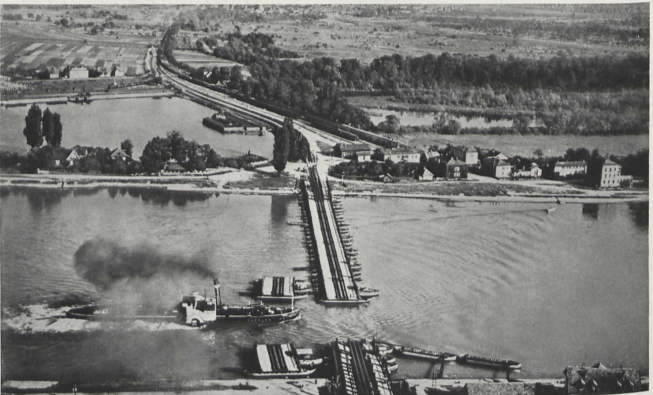
Bild 7. Alte Schiffbrücke bei Maxau
