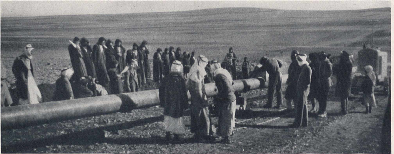
Bild 1. Arabische Eingeborene Palästinas bestaunen die Wunder des elektrischen Lichtbogens. Sie folgen den Schweißtrupps, die in raschem Fortschreiten die einzelnen Teile der Irak-Petroleum-Rohrleitung miteinander verbinden.
