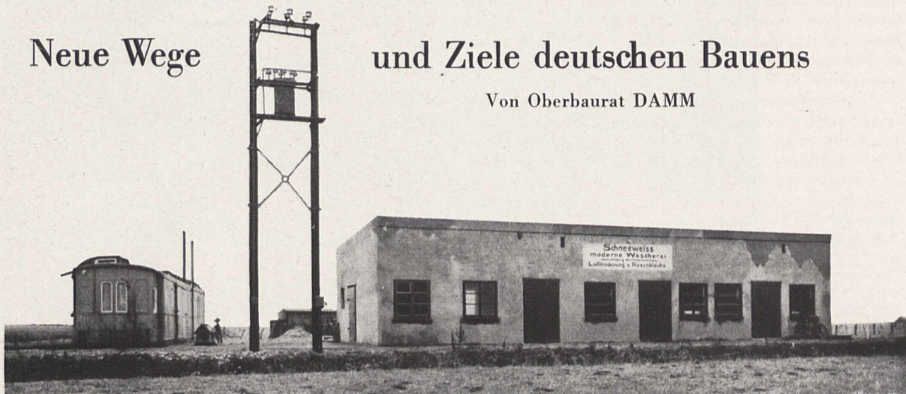
Bild 1. Pfscherbauweise: Dem Gebäude fehlt ein schützendes Dach. Die Feuchtigkeit dringt auch von unten in das Haus ein, das mit seiner „Wagenburg“ wie eine Anlage in der dörflichen, teils landhausmäßigen Umgebung herumsteht
