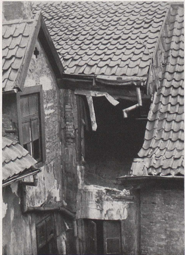
Bild 11. Blick in den Innenhof eines alten Baublocks mit enger Hinterhausbebauung
