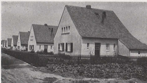
Bild 8. Bessere und klarere Haustypgestaltung als in Bild 7 in handwerklich guter Durchführung. Daher billigere Unterhaltung und gefälligeres Aeußeres eines kleinen Siedlerhauses, das nicht mehr scheinen will, als es ist
