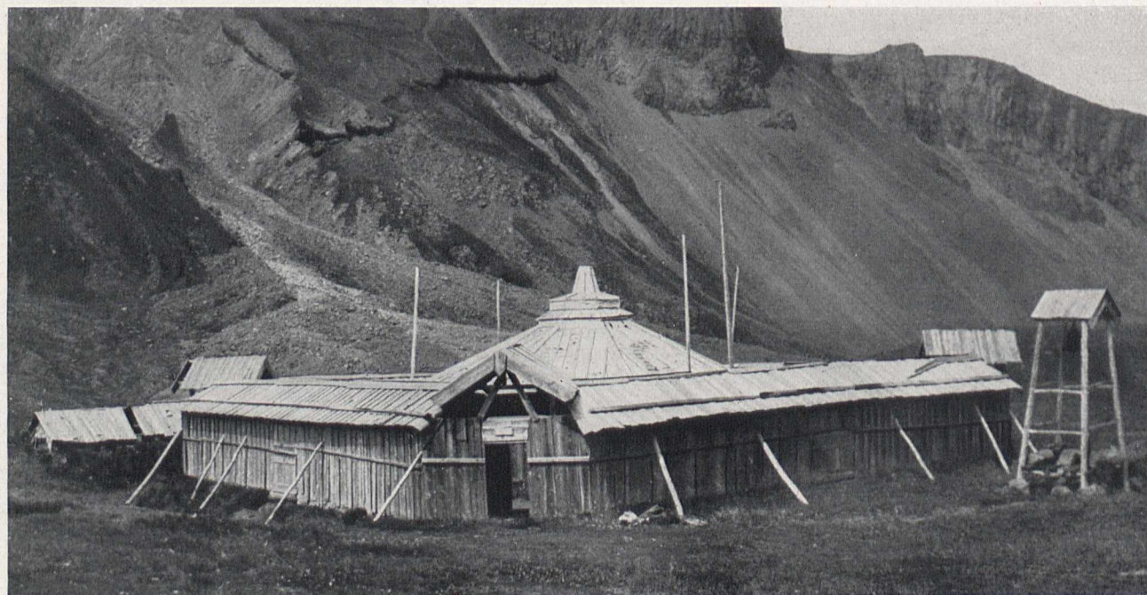
Bild 11. Das buddhistische Kloster am Ufer des „Himmlichen Sees“. Das aus dnnen Brettern und Stangen erbaute, unbewohnte Kloster liegt in etwa 2250 m Hhe. Der quadratische Hof umschliet das achteckige, in chinesischem Stil errichtete Heiligtum. Hinten die Steilhange des Sungaridurchbruches durch das Ringgebirge. (Leica-Aufnahme des Verfassers)
