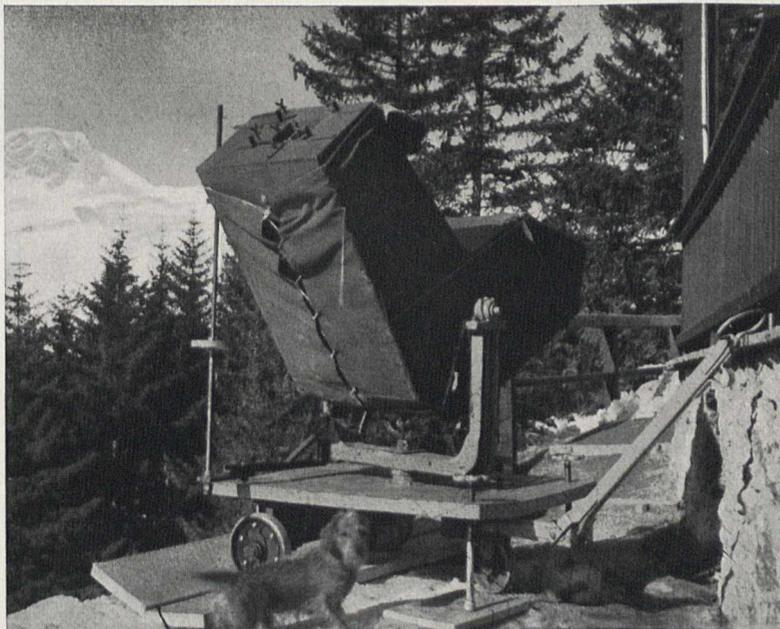
Bild 3. Tromsöer Nordlichtspektrograph zur Ozonmessung
