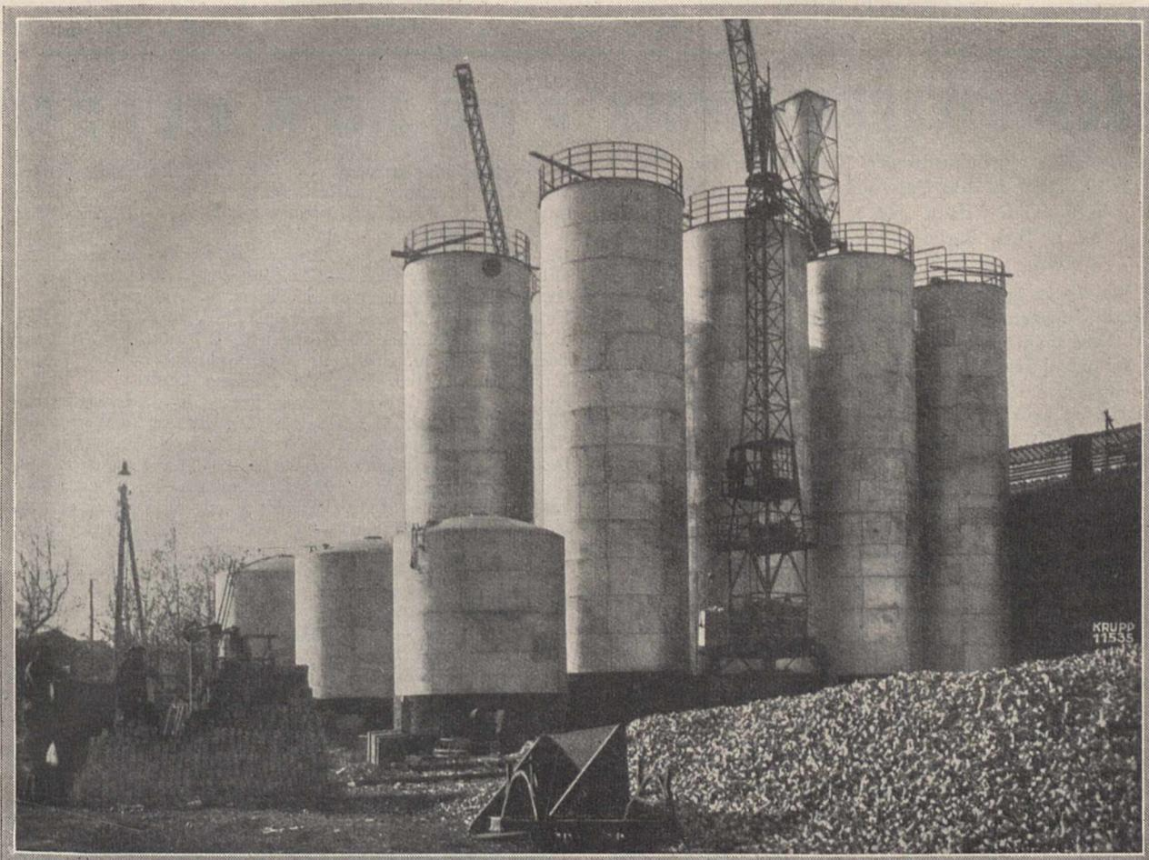
8 Absorptionstürme aus Krupp-V2A-Supra-Stahl von 6 m Durchmesser und etwa 20 m Höhe sowie 3 Lagerbehälter aus Krupp-V2A-Supra-Stahl von 6 m Durchmesser und 5 m Höhe, auf der Baustelle zusammenschweißt. Türme und Behälter wurden für eine von der Yamag-Meguin A.-G., Berlin, im Ausland errichtete Anlage hergestellt.
