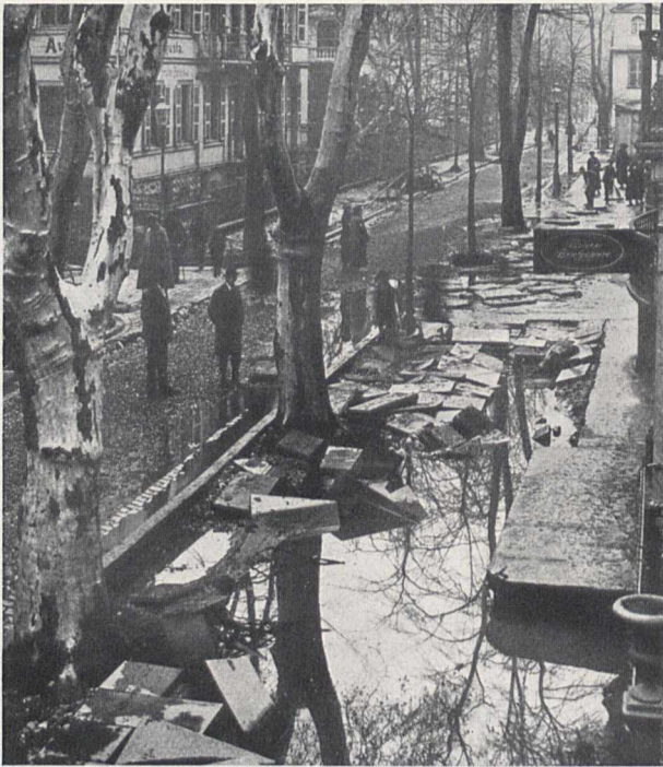
Bild 8 (oben). Zustand einer Straße nach dem Ablauf eines großen Hochwassers
