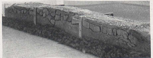
Bild 3. Querschnitt durch eine römische Dammstraße
