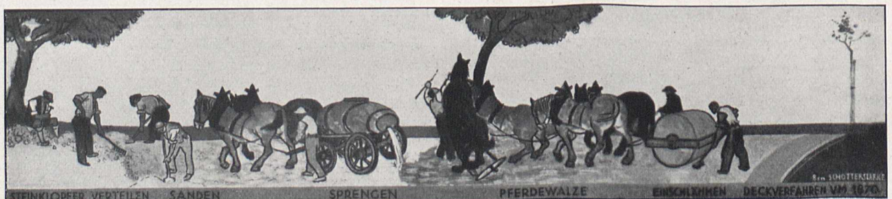
Bild 4. So wurden die Straßen um 1870 gebaut (Sämtliche Abbildungen 1 bis 10 nach Bildern aus der Münchener Ausstellung „Die Straße“)
