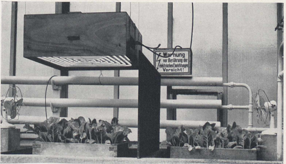
Bild 3. Beleuchtungsanlage im Gewächshaus
