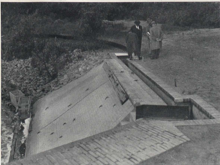
Bild 2. Fanggraben für Wollhandkrabben am Grützter Havelwehr. — Auf dem Wehr kriechen Wollhandkrabben empor und fallen dann in den Graben. Photo: Dr. Röhler
