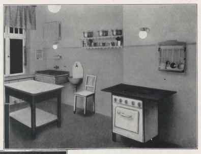
Bild 7. In der Küche spendet die geschlossene Opalglasleuchte die Allgemeinbeleuchtung; Herd und Spültisch erhalten gesondertes Licht zum Arbeiten
