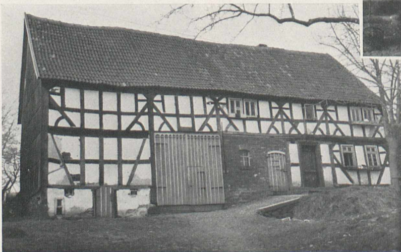
Bild 3. Im Fachwerk kehrt der „Wilde Mann“ wieder, wahrscheinlich ein Symbol für Wodan
