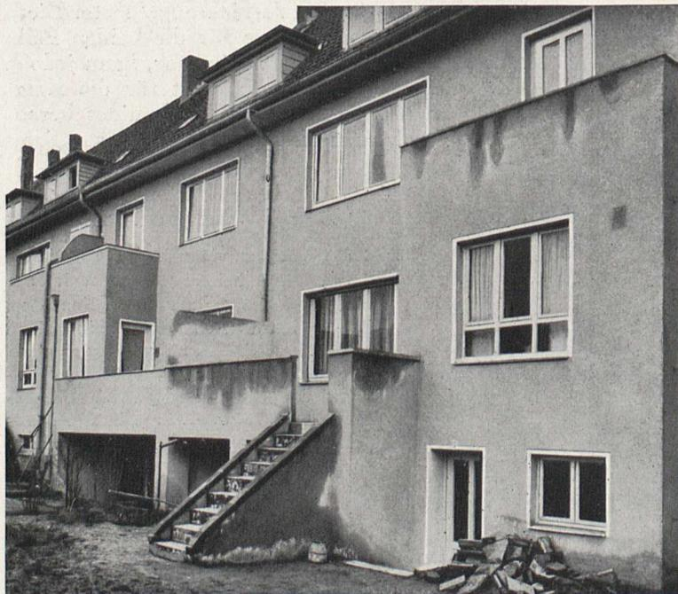
Bild 3. Ein Zwillingsspaar: der linksseitige gesund, der andere, rechts, krank gleich nach der Geburt. Die Vorbauten links haben Metallabdeckung mit „Tropfnase“; die rechtsseitigen nur eine Steinabdeckplatte ohne Nase; der Regen kann daher ungehindert in Putz und Mauerwerk eindringen.
