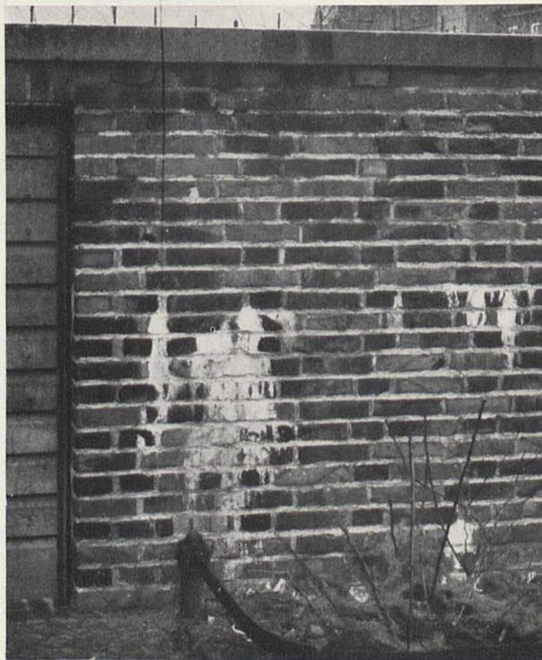
Bild 10. Diese Abdeckplatte scheint an sich richtig zu sein. Sie schützt vollkommen die obere Mauerhälfte; aber ihr Schutz wäre noch wirksamer, wenn sie auf beiden Seiten mehr überstände.
