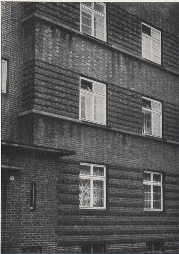
Bild 4. Gesimse ohne Tropfnase leiten den Regen nicht ab. Beim Herabfließen am Hause hinterläßt der Regen häßliche Triefspuren.
