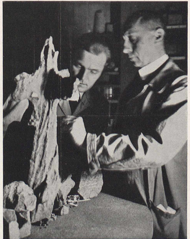
Bild 13. Der Verfasser (rechts: Prof. Steinmetz) unseres Aufsatzes an einer stark verwitterten Sandstein-Fiale
