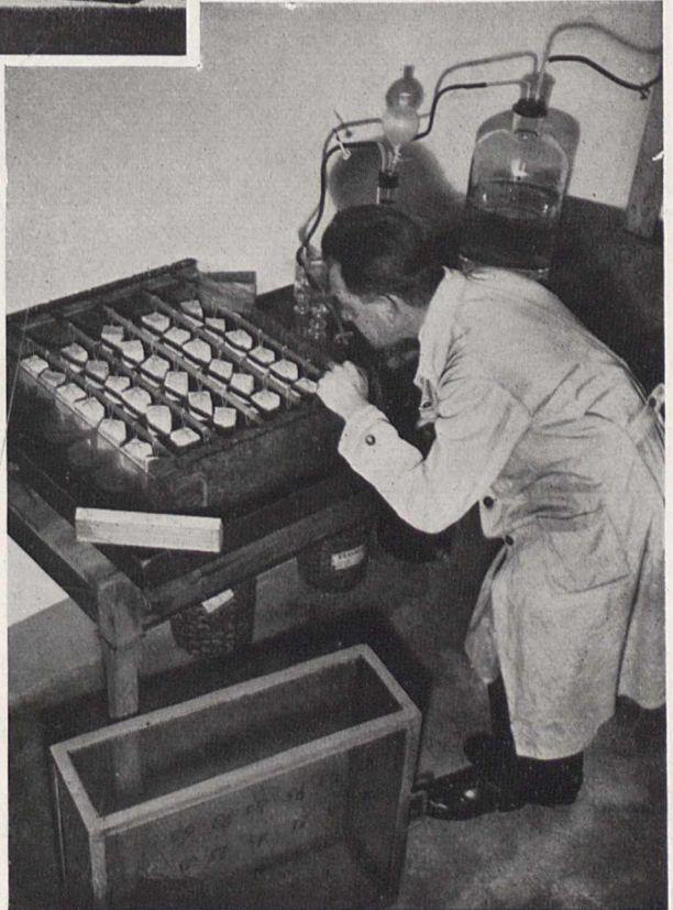
Bild 8. Wetterabseitenverwitterung an Probewürfeln aus Sandstein
