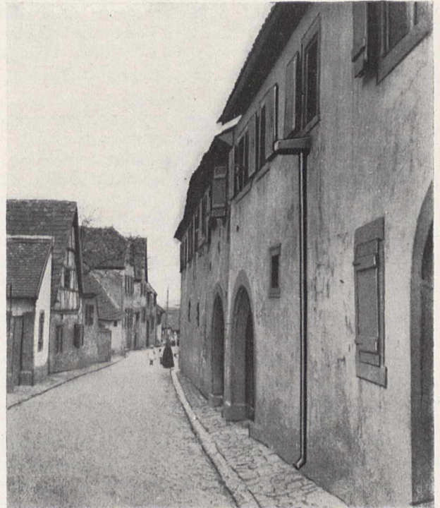
Bild 6. Um die Vorübergehenden vor unsauberen Ergüssen zu schützen, wurden die Wasserspeier zuweilen mit Abfallrohren in Verbindung gebracht (Oberhambach)
