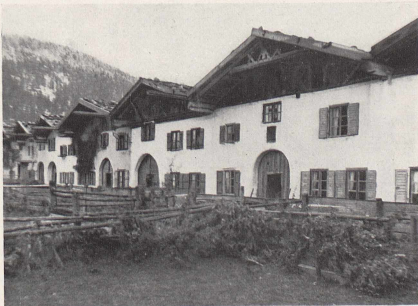
Bild 8. Wo Gossensteine nie gebräuchlich wurden, konnte schon in alter Zeit die Aneinanderschließung der Häuser ohne enge Reihen erfolgen (Mittenwald)
