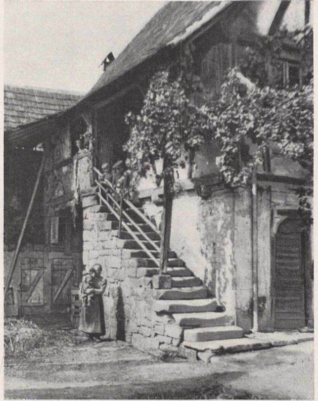
Bild 4. Das Hinuntertragen des Schmutzwassers auf der großen Freitreppe ist besonders bei schlechtem Wetter sehr lästig (Oberrotterbach)
