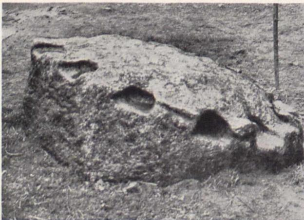
Bild 1. Stein in Jühlsdorf. Die Steinmetze pflegen auch in neuerer Zeit flache Risse zwischen den Löchern einzumeißeln, damit der Stein leichter in der gewünschten Richtung spaltet. Aber nicht immer hat diese Maßregel den gewünschten Erfolg, wie das Bild zeigt
