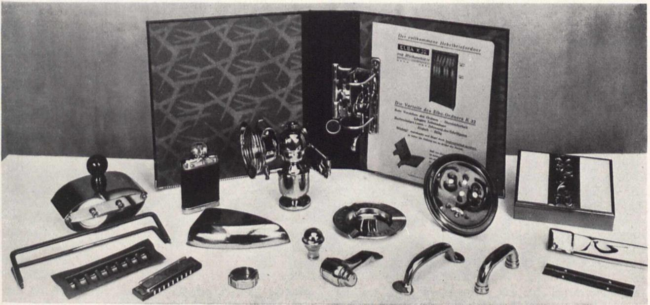
Bild 3. Anwendungsbeispiele für galvanisch veredelten Stahl
