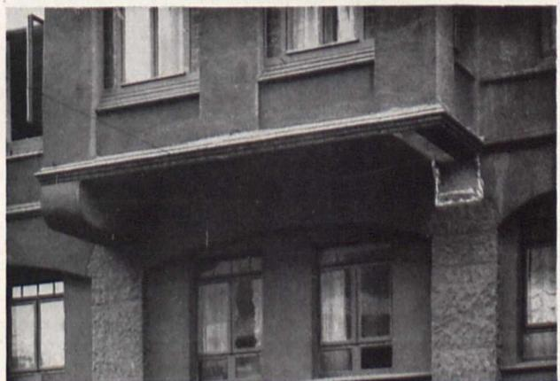
Bild 3. Eine der beiden kräftig ausgebildeten Konsolen ist herabgefallen. — So wird deutlich, daß sie nur scheinbar den Balkon trug
