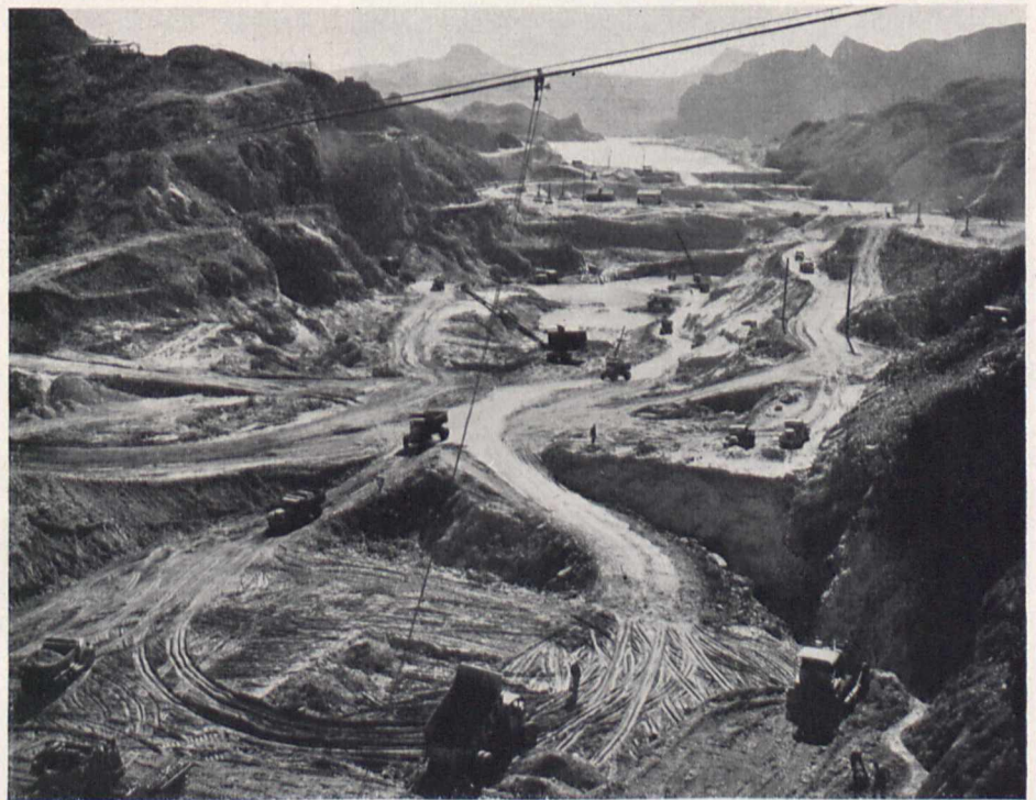
Bild 3. Der All-Amerika-Kanal zapft den Colorado-Fluß an, um Kalifornien Wasser zuzuführen. An einzelnen Stellen wird der Kanal so tief gelegt, daß er auch vom Grundwasser gespeist werden kann
