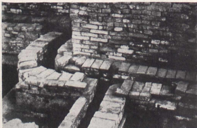
Bild 4. Teil der Kanalisation; das Siel führt um eine Hausecke herum; Decksteine abgenommen
