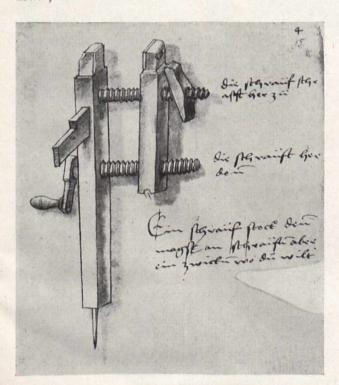
Bild 2. Der erste Schraubstock. — Zeichnung in der Bilderhandschrift von Martin Löffelholz, Nürnberg, 1505
