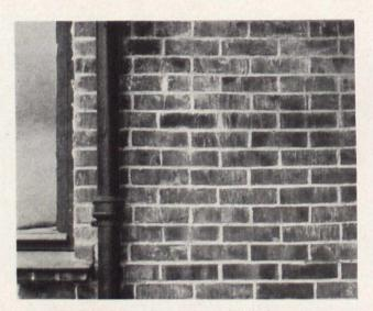
Bild 2. Schlecht abgesäuertes Mauerwerk
