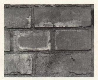
Bild 1. Mauerausschnitt mit Ausblühungen und Zerstörungserscheinungen
