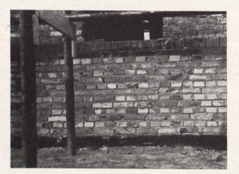
Bild 3. Auswitterungen auf dem Sockel eines Rohbaues
