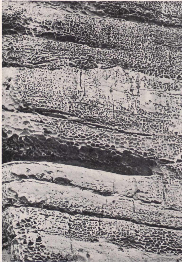
Bild 5. Netz- oder Wabenverwitterung des Quadersandsteins. Gebiet des Brand
