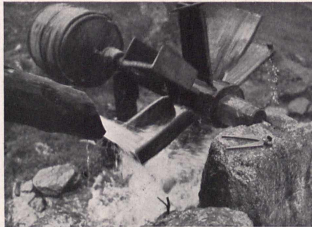
Bild 3. Das Turbinenrad von der Kopflagerseite. Als Lager dient einfach eine Einarbeitung in einem an Ort und Stelle vorhandenen Felsblock. Jahrzehntelanger Betrieb hat den Stein an der Lagerstelle spiegelglatt geschleuert. Die Zange im Vordergrund läßt die Größenverhältnisse erkennen. Die „Schaufeln“ des Laufrades sind durch vom Wasser mitgetriebene Steine sowie durch den rauhen Dauerbetrieb zum Teil beschädigt
