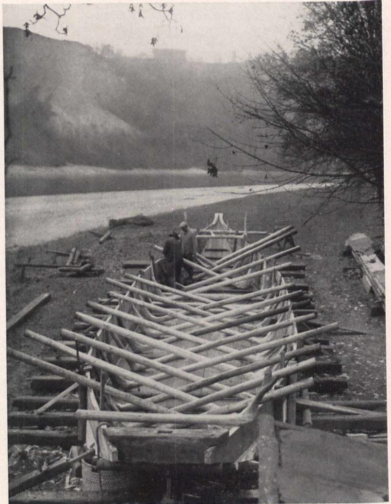
Bild 2. Die Kipfern sind nach ihrer Stärke in das Schiff gelegt worden; Meister und Gehilfe schneiden sie zu
