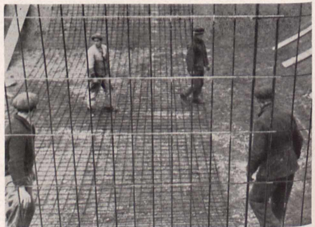
Bild 4. Schwimmbecken aus Eisenbeton mit Baustahlgewebematten in Wänden und Boden des Beckens
