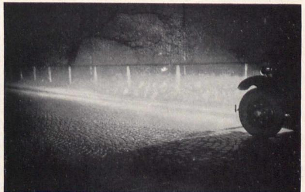
Bild 5. Uebersicht über die Fahrbahn bei Einschaltung eines Breitstrahlers mit Kippspiegel, der ein besonders schräg nach unten gelenktes Lichtband ergibt
