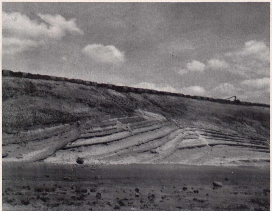
Bild 2. Sanddünen im Untergrund der Marsch. Aufnahme aus der Sohle der Schleusenbaugrube
