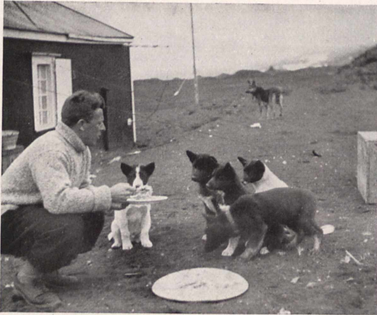
Bild 5. Unser Mitarbeiter beim Füttern der jungen Stationshunde. Man sieht deutlich die Drahtseilverspannung des Hauses
