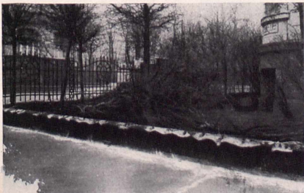
Bild 6. Mit Natursteinsockeln sollte man bei der Entgitterung nicht so roh umgehen wie hier
