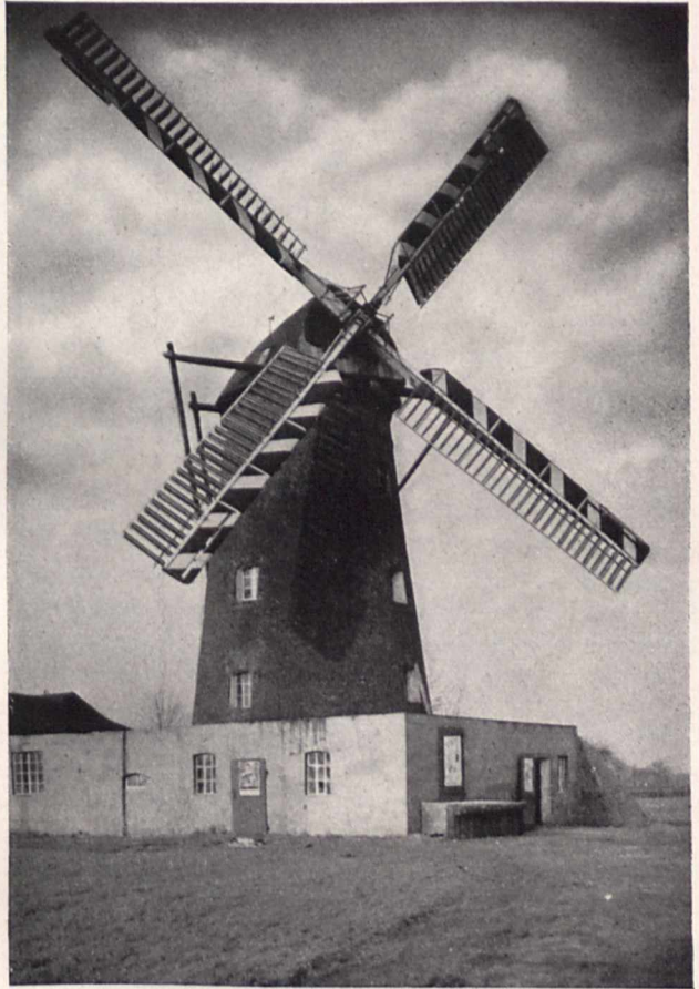
Bild 2. Turmwindmühle, System Bilau Ventikantenflügel mit Jalousien
