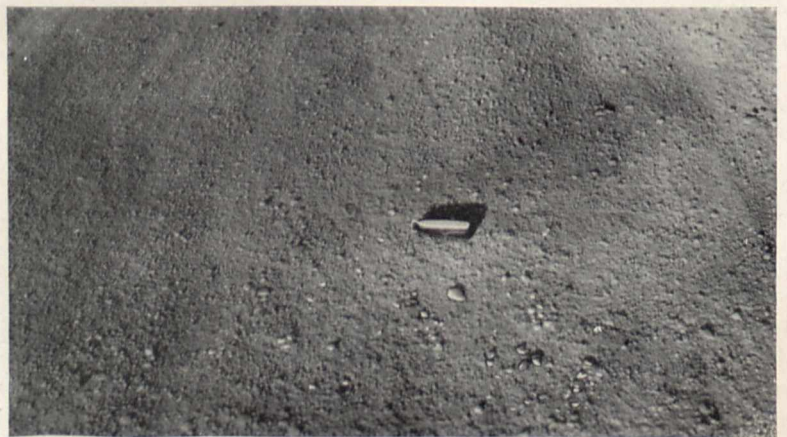
Bild 6. Die zwar rauhe, dafür aber rutschsichere Oberfläche einer fertiggestellten Salzstraße
