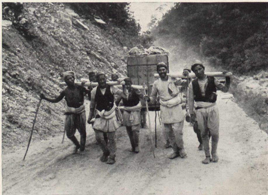
Bild 3. Ein Turbinenteil wird befördert — auf dem Rücken von 1\frac{1}{2} Dutzend Kulis über die Pässe nach Kathmandu
