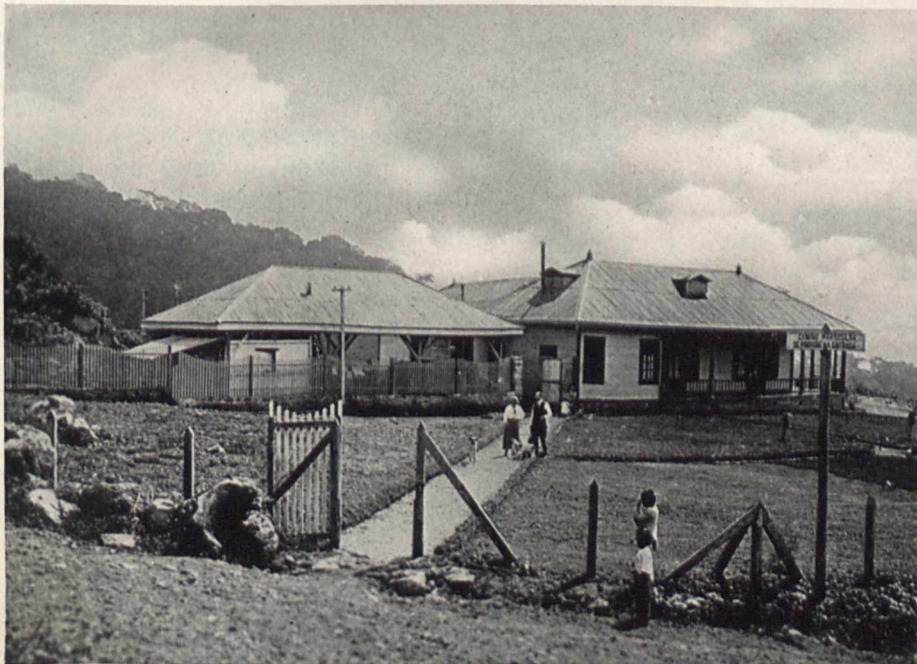
Bild 4. Luftige Villa in Guatemala. Erbaut für die Direktoren eines deutschen Elektrizitätswerkes in Santa Maria de Jesus, Quezaltenango. Freie Anlage auf einem höheren Hangteil, breite Galerie, ausgiebige Lüftung durch große Fenster und Luken des Dachraumes
