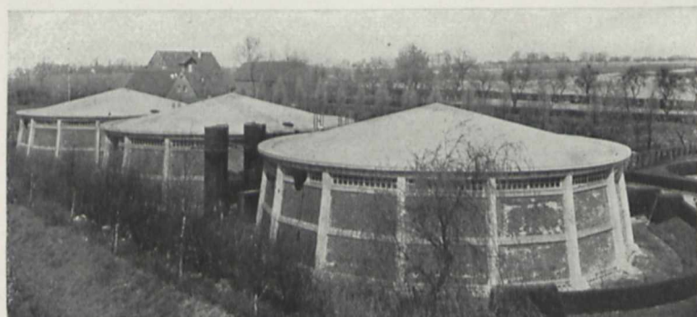
Bild 5. Hochleistungstropfkörper für die biolog. Abwasserreinigung
