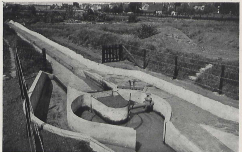
Bild 2. Lotrecht durchflossener Sandfang
